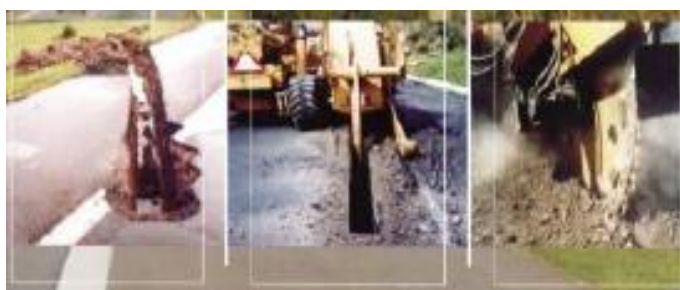
Figura 5– Dreno Sub-superficial de pavimento
