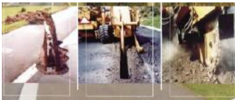
Figura 5– Dreno Sub-superficial de pavimento
