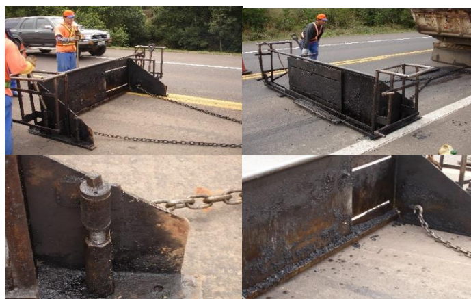
Figura 3 – Dispositivo de nivelamento regulável em altura e largura
